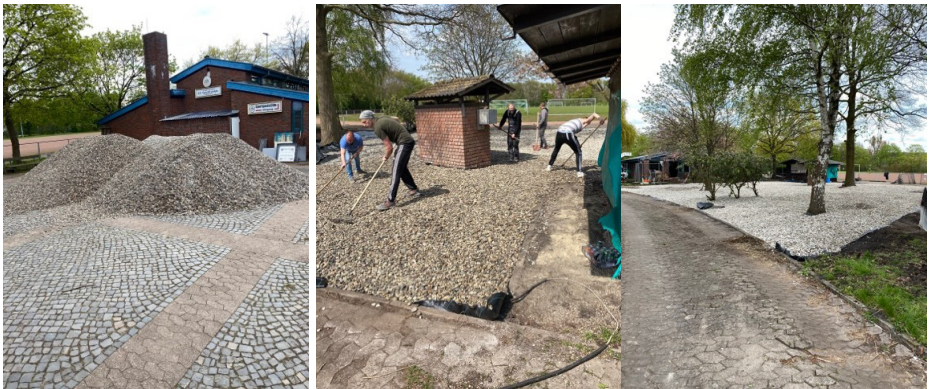
Auch die knapp 40 Tonnen Kies wollen verteilt werden und da kamen die Helfer gerade Recht
