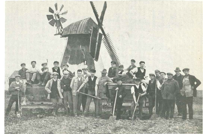
Der erste Spatenstich – mit vereinten Kräften wurde der Mergelboden bewegt.
